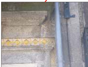
Depósitos sobre a pedra e azulejo por circulação de humidade procedente da varanda.
