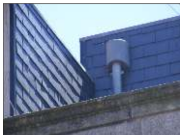
Solução de revestimento em ardósia no piso recuado.
