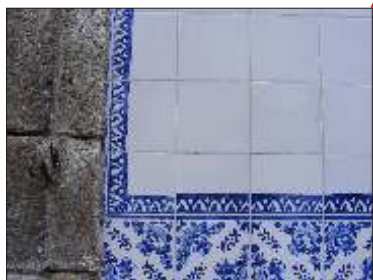
Emprego de réplicas nas áreas de azulejo de padrão e de repetição.
