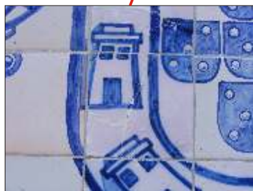
Azulejo fracturado em três e pequena lacuna volumétrica no canto superior esquerdo.
