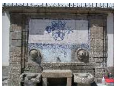
Painel antes da intervenção.
