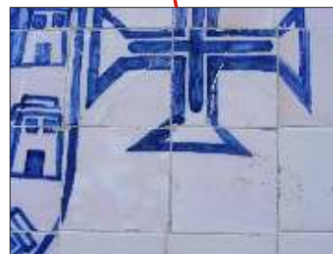
Pormenor de reintegração por “regeneração”.
