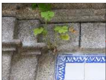
Colonização biológica. Planta vascular que se fixou e desenvolveu nas juntas entre peças de cantaria.
