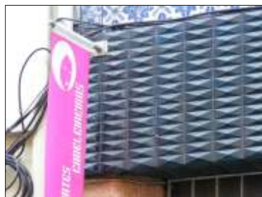
Colocação de cabos de rede e publicidade na fachada.
