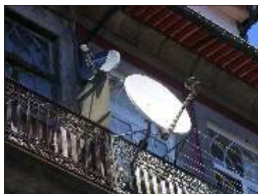
Elementos dissonantes colocados na fachada (duas antenas parabólicas e estendal).
