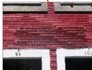
Azulejos biselados, de cor aproximada, foram usados para preencher lacuna no revestimento.
