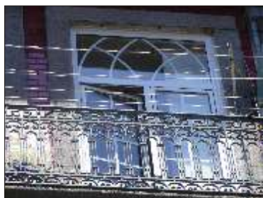
Substituição das janelas por outras em alumínio de desenho aproximado ao original.
